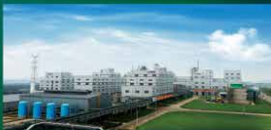
四川能投鼎盛锂业公司年产5万吨高端锂盐项目
