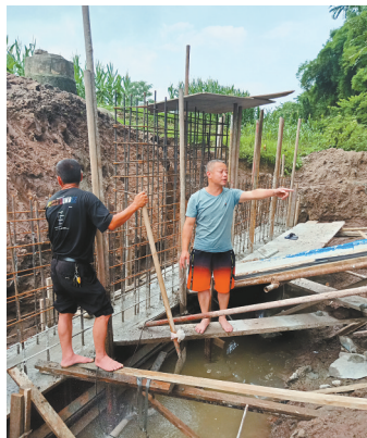
图为叶林森代表在施工现场
