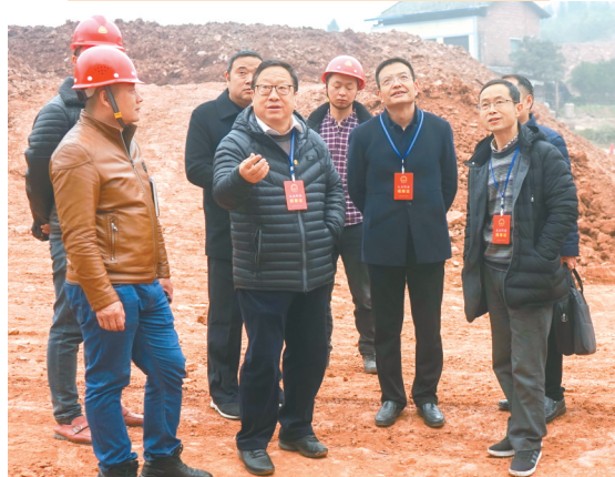
2017年11月，达州市通川区十一届人大常委会主任梅辉太带领常委会组成人员和部分区人大代表调研双河口水库建设项目。
