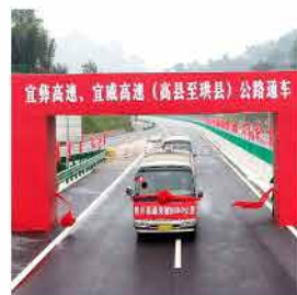
四川高速公路通车里程突破8600公里
