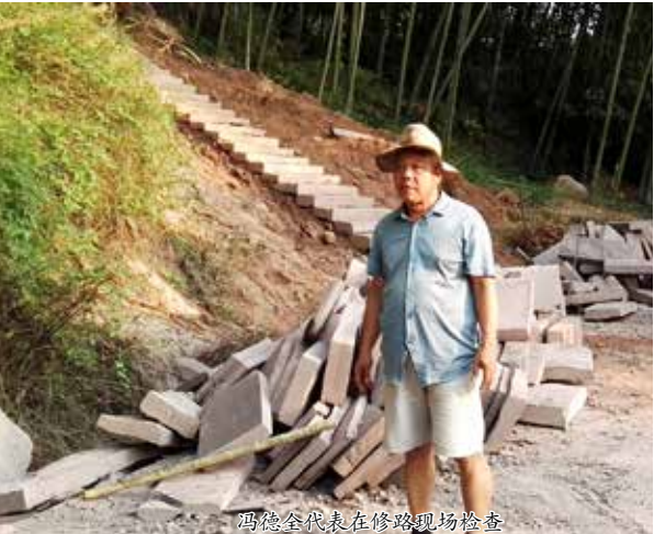
冯德全代表在修路现场检查
