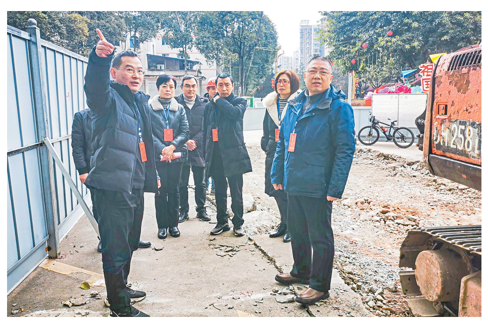
图为县人大代表视察民生实事票决项目城区排水管网改造施工情况。
