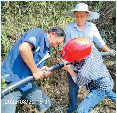
徐良田(左一)在山间安装水管。
