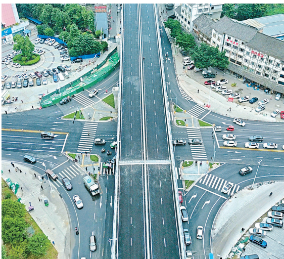
高速公路乐山城区连接线二期(全福连接线)工程。
