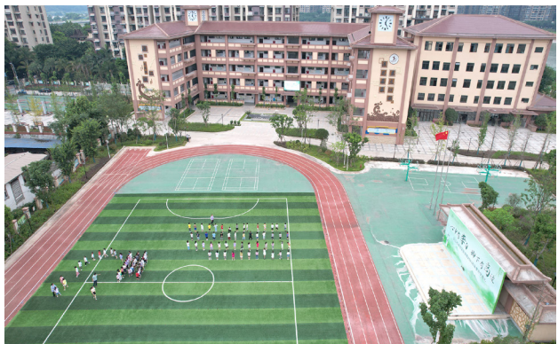
肖坝小学（票决项目）建成投入使用
