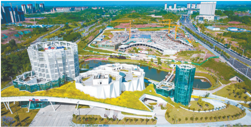
图为正在建设中的人工智能产业园区。(宋姿熠 摄)
