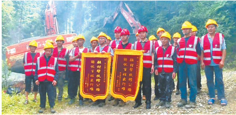
回龙村涧溪沟产业路施工现场。
