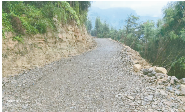
回龙村涧溪沟产业路,通过修缮之后,从宽不足一米的小路变为可以通过农用车的大路。
