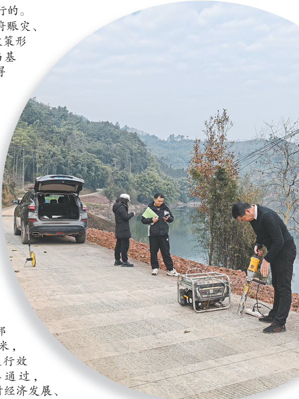
山水村村支书正在“打公路”,验收项目工程。
